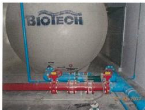
ภาพถ่ายที่ 2.2-59 ถังสำรองน้ำใช้บนหลังคา
