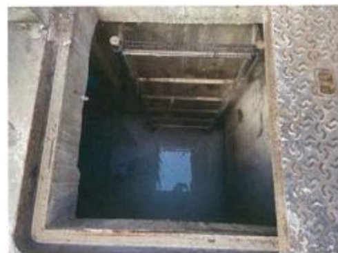
ภาพถ่ายที่ 2.2-18 ป่อกักเก็บน้ำเสียจากของเสียอันตราย (Storage Tank)
